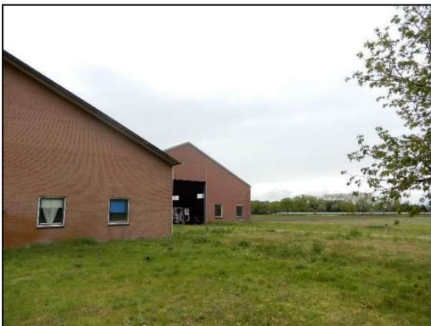
Foto I – Loods (Collse Hoefdijk 34)
